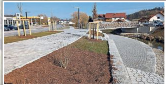
Im Zuge der Hochwasserfreilegung konnte der Ortskern von Ascha neu gestaltet werden.
