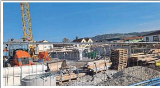
Auf dem ehemaligen „Penker“-Gelände entsteht ein Gebäude mit 40 Wohneinheiten und einer Tagespflegeeinrichtung.
