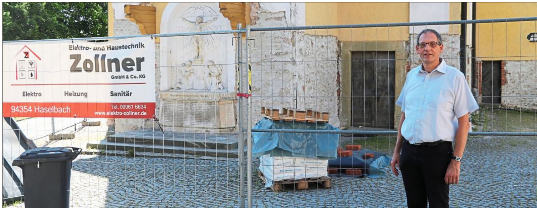
Stillstand hinter dem Bauzaun: Wegen eines Fledermausquartiers unter dem Dach müssen die Sanierungsarbeiten an der Kirche Sankt Georg momentan ruhen. Pfarrer Dominik Daschner setzt sich nun für eine den Umständen entsprechende Fortsetzung des Baubetriebs ein. Fotos: David Salimi
