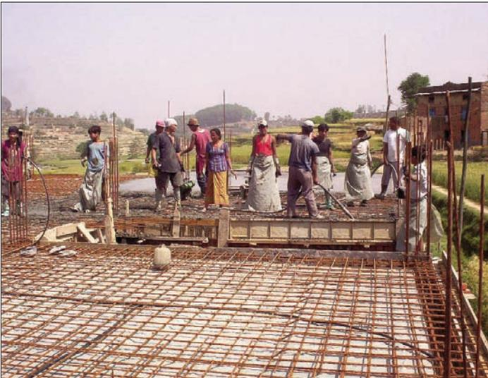
*Auf der Baustelle beim Betonieren der Decke*
