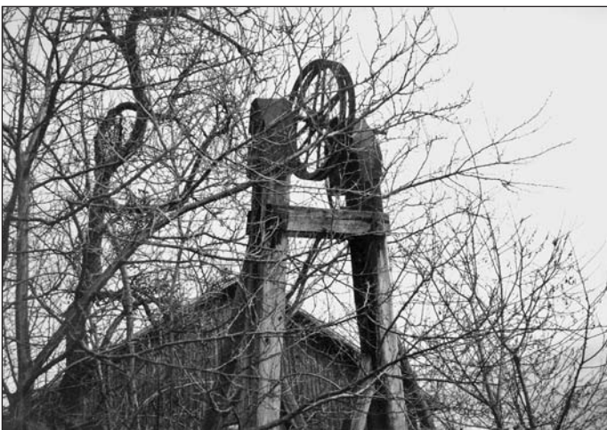
Stützsäule mit Umlenkkrollen (doppelt)
