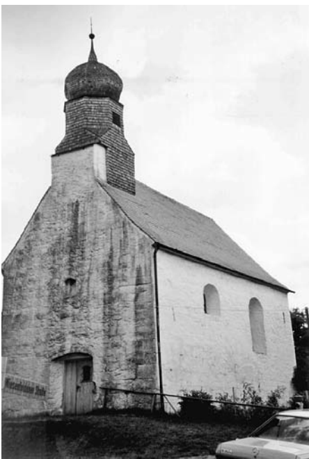
Bild 1: Die Kirche von Südwesten
