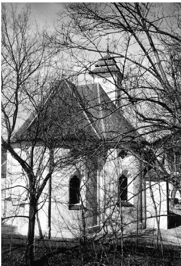
1734 wurde die schon recht baufällige Schloßkapelle abgerissen und auf dem Dorfplatz daneben die heutige St. Georgskirche erbaut.
