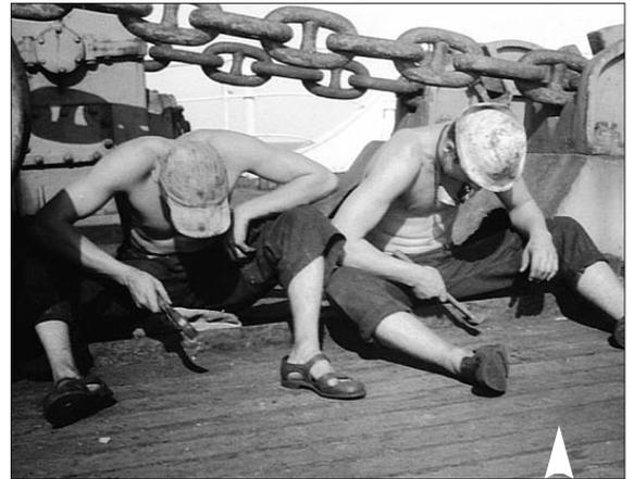
Rostklopfen am Fundament der Ankerwinde
