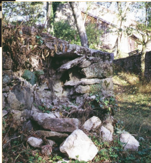
Der Zustand der Burgmauer war in einigen Bereichen schon so schlimm, dass Betonwände zur Stützung nötig wurden, andere Bereiche benötigten nur eine „kosmetische“ Behandlung.
