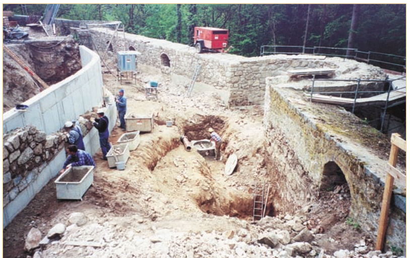
Der Zustand der Burgmauer war in einigen Bereichen schon so schlimm, dass Betonwände zur Stützung nötig wurden, andere Bereiche benötigten nur eine „kosmetische“ Behandlung.
