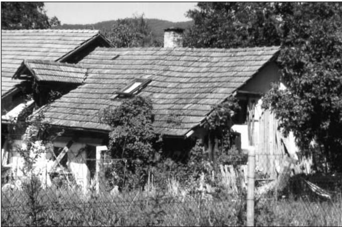
Ehemal. Hirtenhaus von Forst, z. Zt. im Umbau (Foto 2004)
