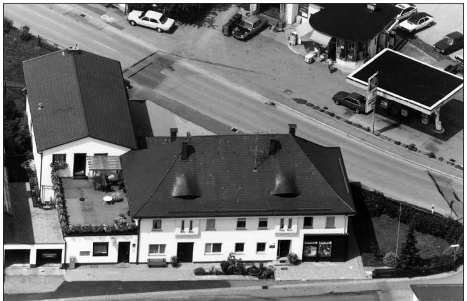
Das Gebäude der früheren Bau- und Möbelschreinerei Seebauer in einer Luftaufnahme aus dem Jahre 1977: Die St. Georgs-Apotheke (Inhaber Werner Höning) und die Post zogen 1976 in die Burgstraße 66 um, nachdem bereits 1975 die neue Werkstatt an der Straubinger Straße (jetzt Stockackerweg) fertig geworden war. 1992 bezog Zahnarzt G. Boyen die ehemaligen Lagerräume.
