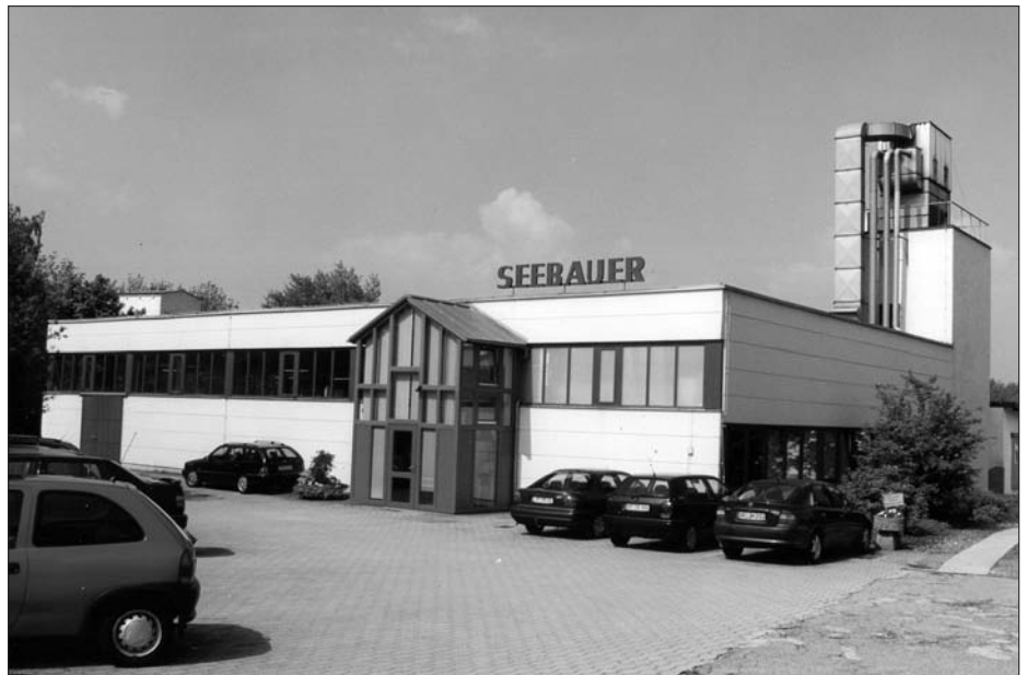
So präsentiert sich die Werkhalle der Schreinerei Seebauer, die 1975 gebaut wurde, im Jahre 2004.
