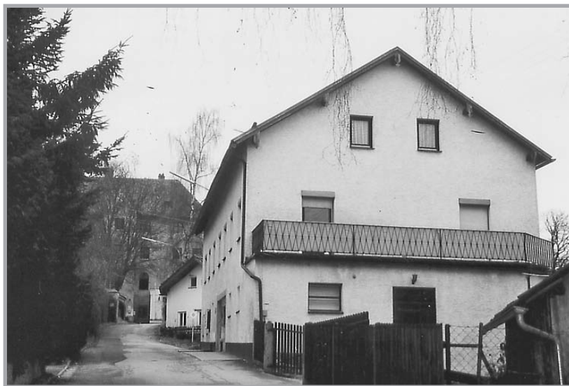
Knott-Haus war einst das Gerichtsdiennerhaus in Falkenfels (Aufnahme 2001)
