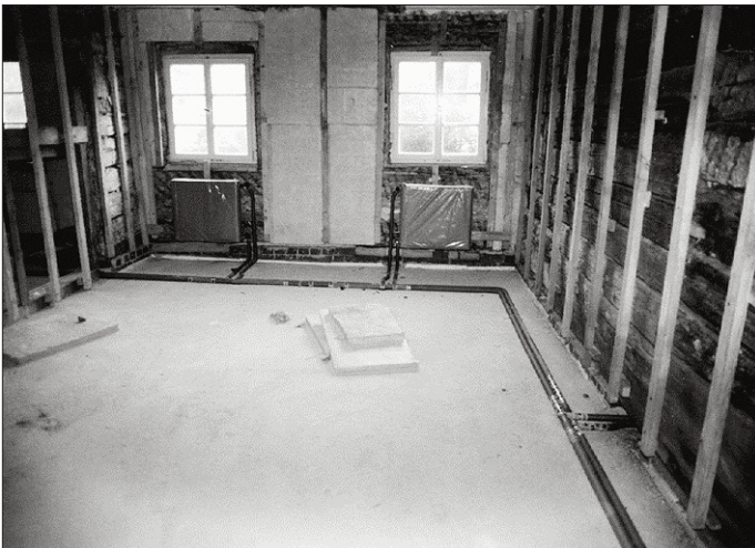
Heizungsinstallation und Leitung für Trockenbau
