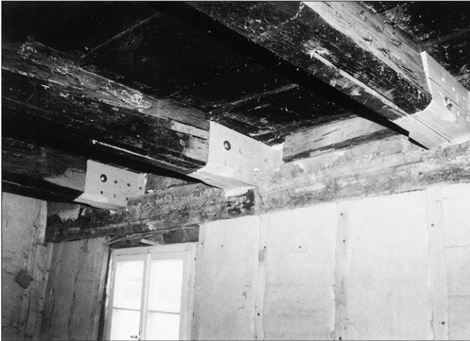
Historische Deckenbalken wurden verlängert.
