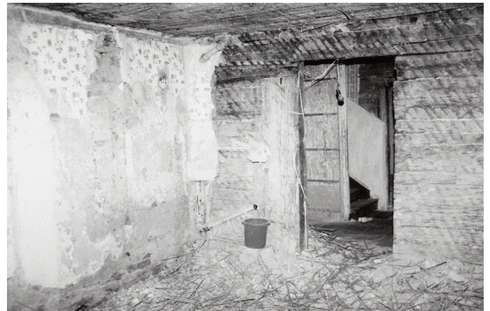
Der Zementpanzer ist teilweise entfernt.
