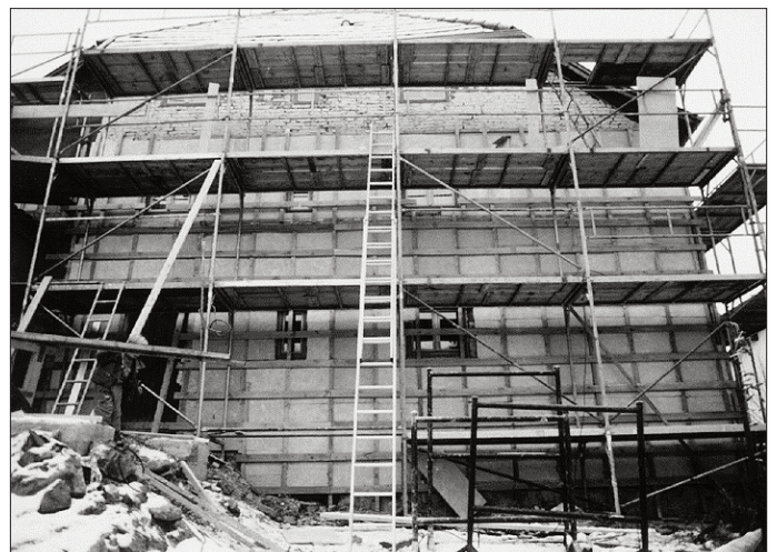
Der massive Anbau wird gedämmt.
