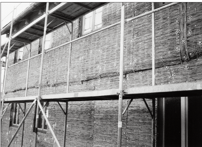
Die Schilfdämmung wird auf den Blockbau aufgebracht.
