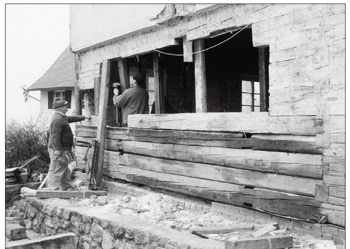
Der Blockbau wird ausgebessert.
