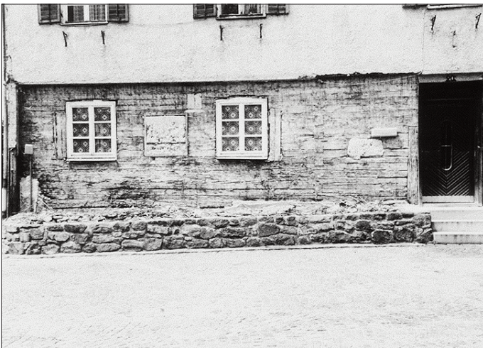
Erdgeschoss: Außenwand, Südostecke
