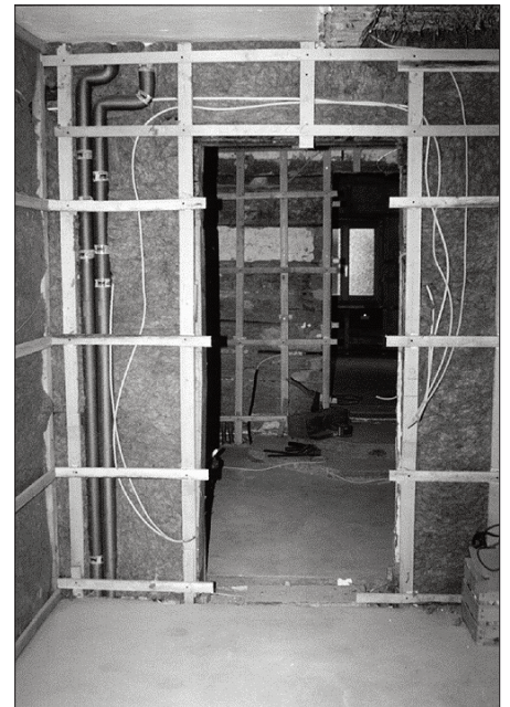
Wandunterkonstruktion für den Trockenbau
