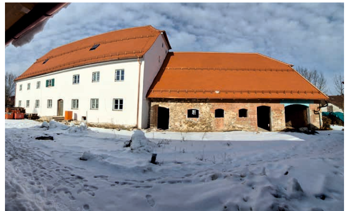
Die umfassende Sanierung des Gasthauses Gschwendt ist für Wolfgang Zirngibl von besonderer historischer Bedeutung.
