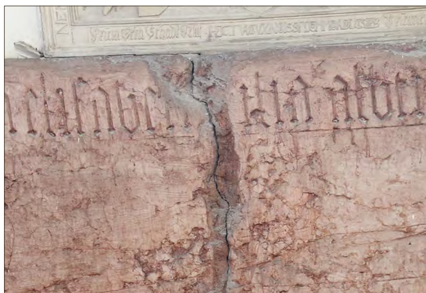
Von oben bis unten durchgebrochen ist auch dieser rote Grabstein, der an der Südwand der Totentanzkapelle befestigt ist.
