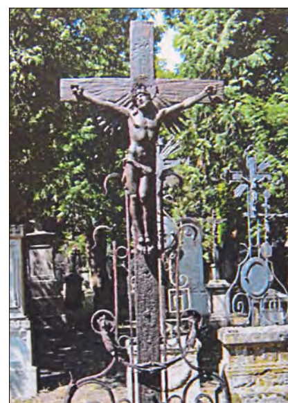
Die schmiedeeisernen Grabkreuze, insgesamt sind es rund 250, müssen regelmäßig gereinigt, entrostet und konserviert werden.
