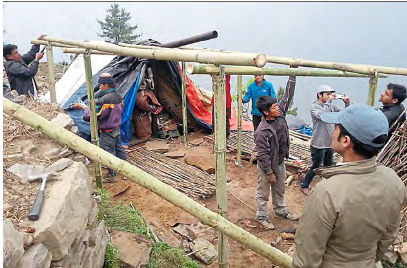
Hütten werden provisorisch wieder aufgebaut.
