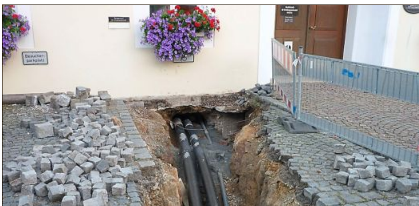
Das Rathaus wurde an das Nahwärmenetz angeschlossen.
