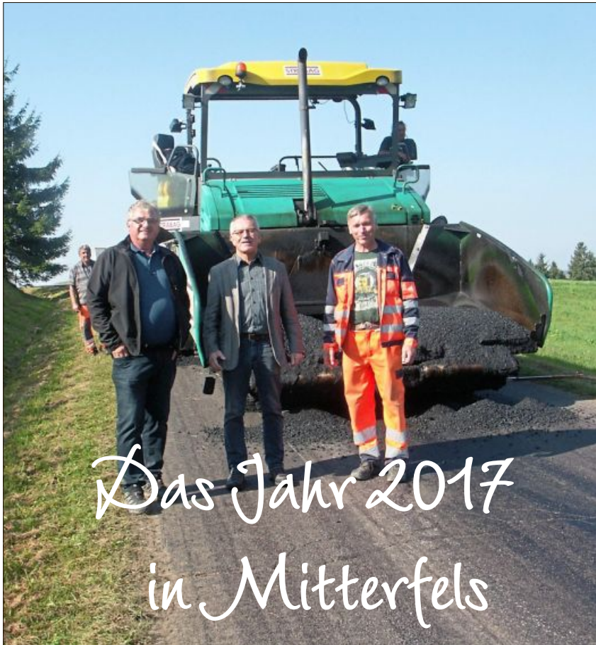
Laufend finden Ausbesserungen von Straßen statt, wie hier in Aign.
