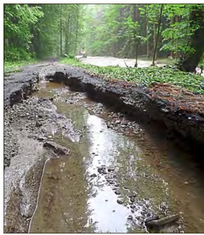
Die Wege im Perlachtal wurden zum Teil tief ausgespült.
