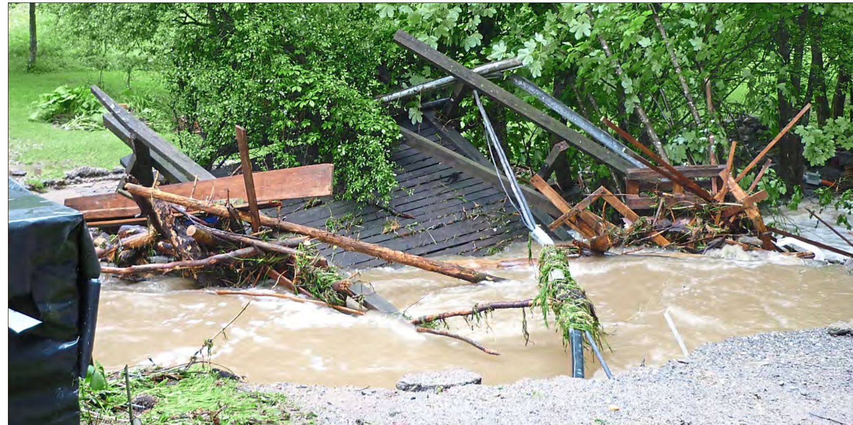
Der Weg zwischen Talmühle und Buchberg im Mitterfelser Perlachtal ist nicht mehr begehbar – die Fluten rissen die Brücke samt Fundament mit sich.
