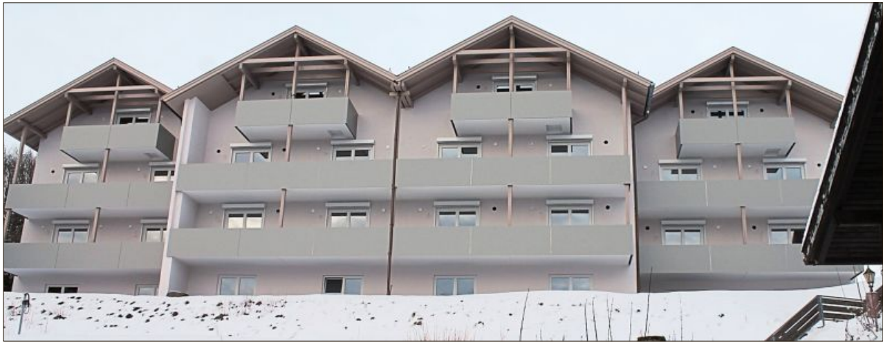
Die vier sanierten Häuser: 18 Wohnungen entstehen derzeit in der früheren Ferienanlage.
