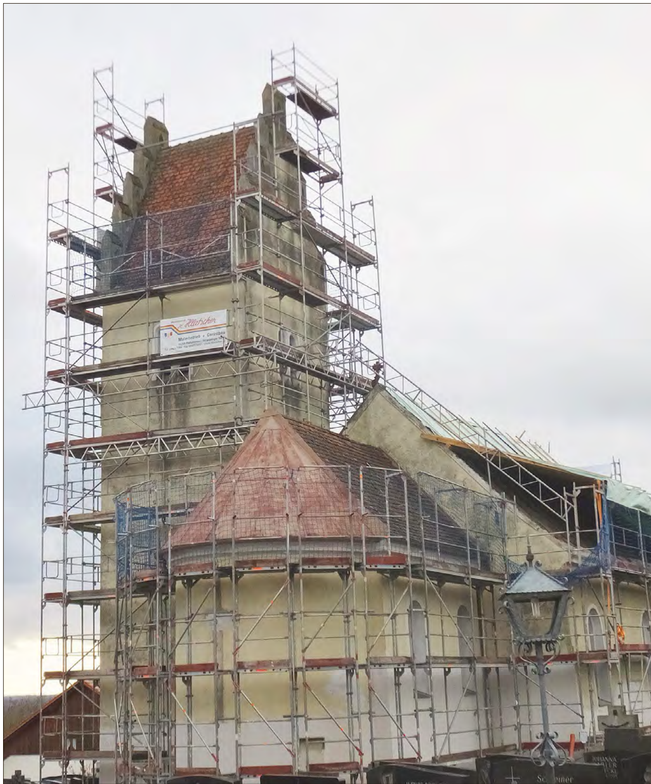
Bei der ehemaligen Münsterer Pfarrkirche und heutigen Neben- und Friedhofskirche St. Martin erfolgt derzeit eine aufwendige Außenrenovierung durch die Gemeinde.
