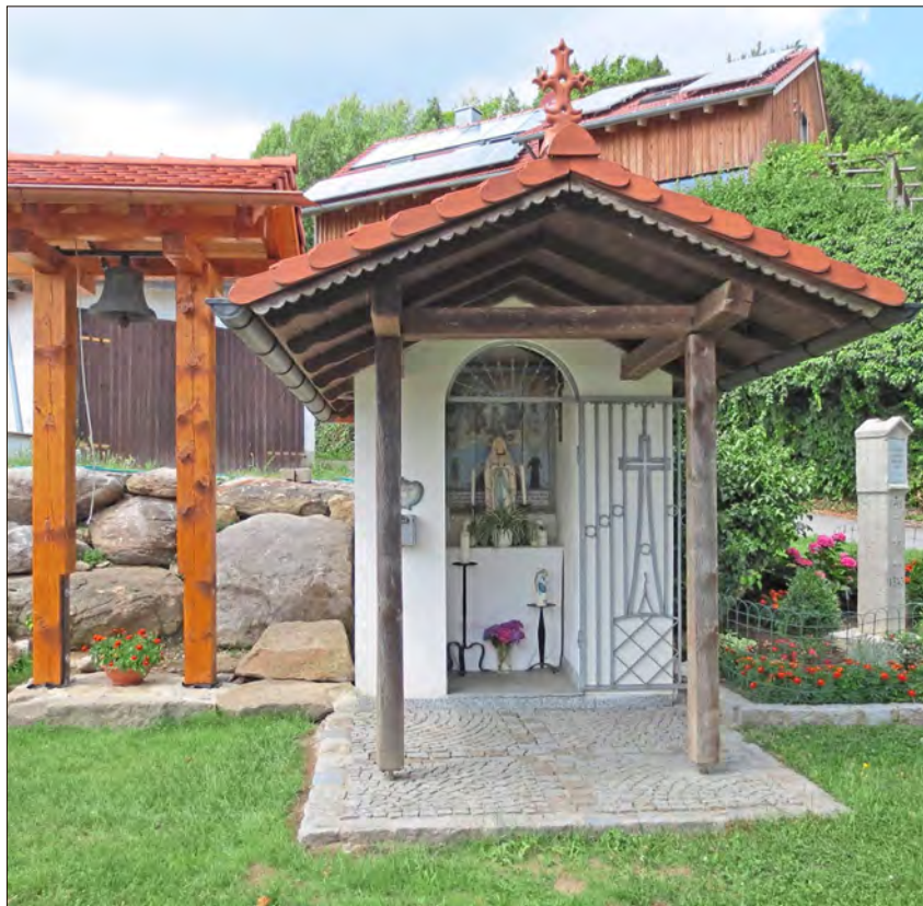
Zum 125-jährigen Bestehen präsentieren sich die Nothelfer-Kapelle, der erneuerte Glockenstuhl und das restaurierte Wegkreuz in neuem Glanz. (Foto: tb)
