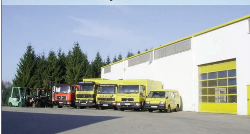
Ein Teil des Fuhrparks mit der neuen Halle
