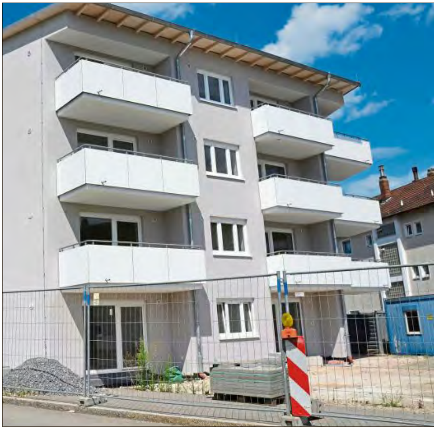
Wohnhaus in Bogen mit zwölf Wohnungen
