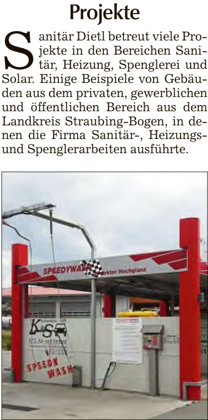
Waschanlage in Mitterfels
