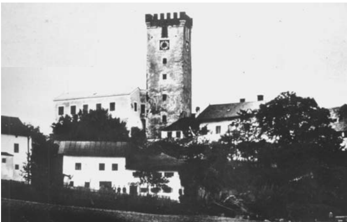
Falkenfels nach dem Brand 1888
