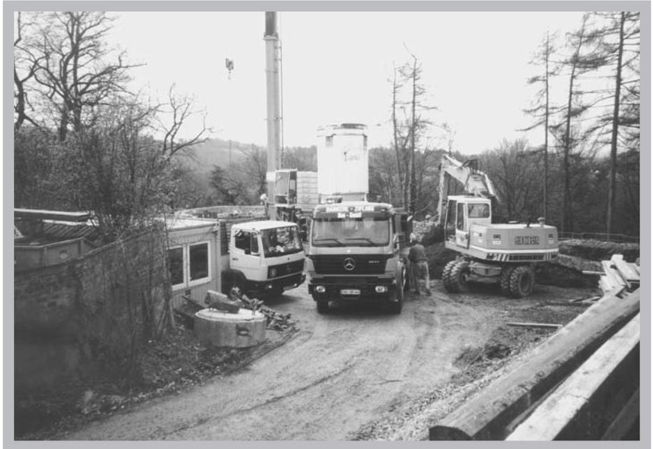
Die Sanierungsarbeiten wurden in verschiedenen Bauabschnitten durchgeführt. Einige Bereiche der Mauern konnten wegen des sehr schlechten Zustandes nicht mehr saniert werden, sie mussten abgebrochen und neu errichtet werden. Für andere Bereiche waren nur Sanierungen zur schöneren optischen Gestaltung erforderlich.
