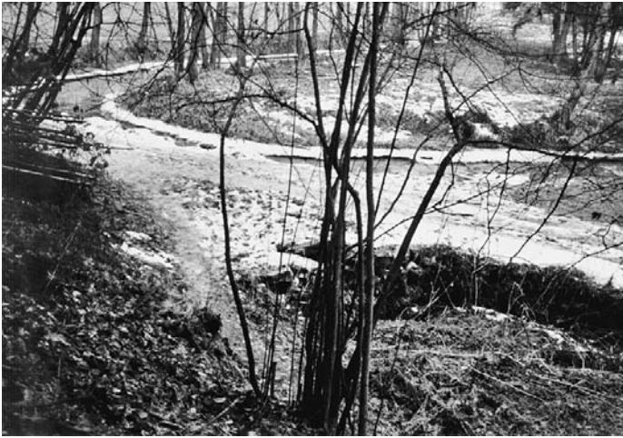
275 m unterhalb der Neumühle waren Einlauf und Schieber
