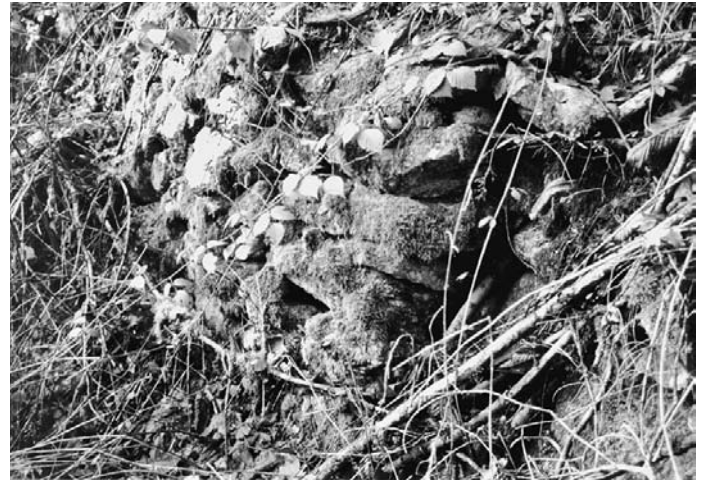
Letzte Erinnerung an die Säge: Mauerwerk längs des Wegs
