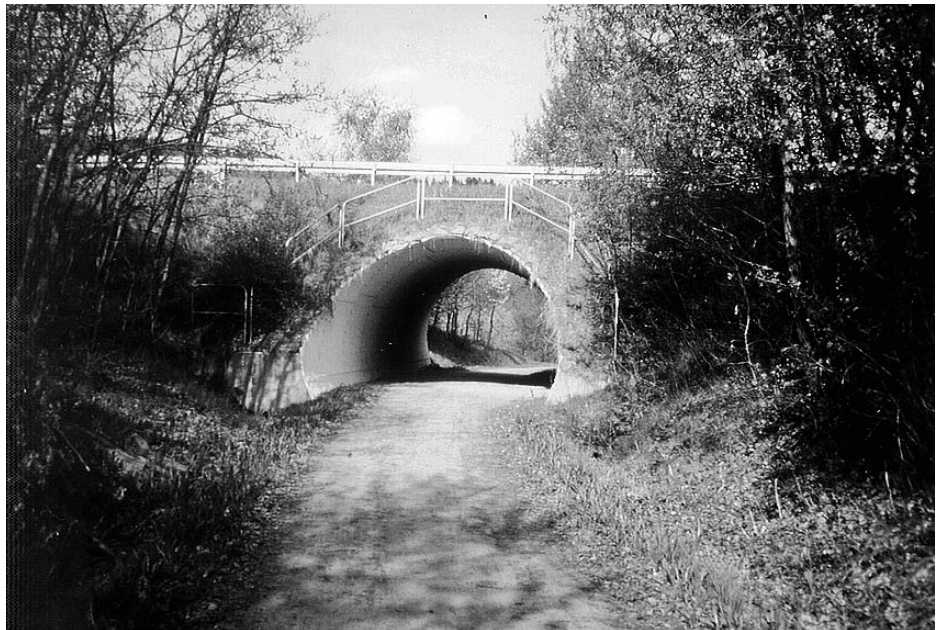
Die neue Brücke in Wiespoint
