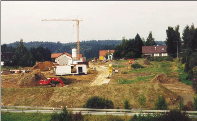
22. September 1996: Das erste Wohnhaus entsteht.
