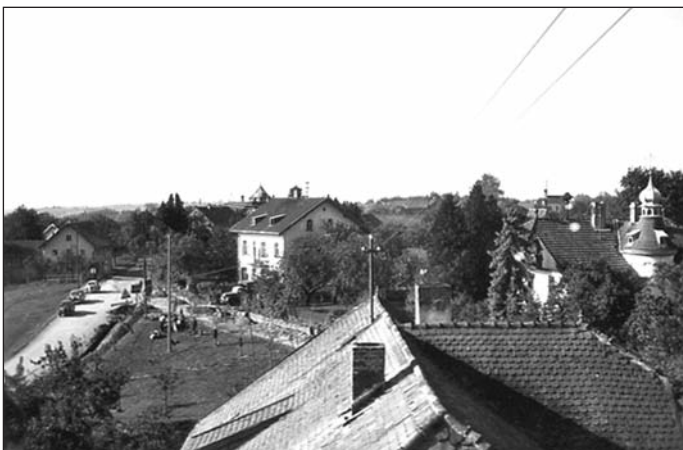
So hat Johann Baptist Grotz die Baustelle von seinem Fotoatelierfenster aus gesehen; rechts die Horneffvilla (heute Pizzeria „Da Nico“).
