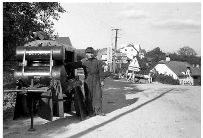
Baustelle mit Teermaschine an der Einmündung der heutigen Lindenstraße in die Straubinger Straße
