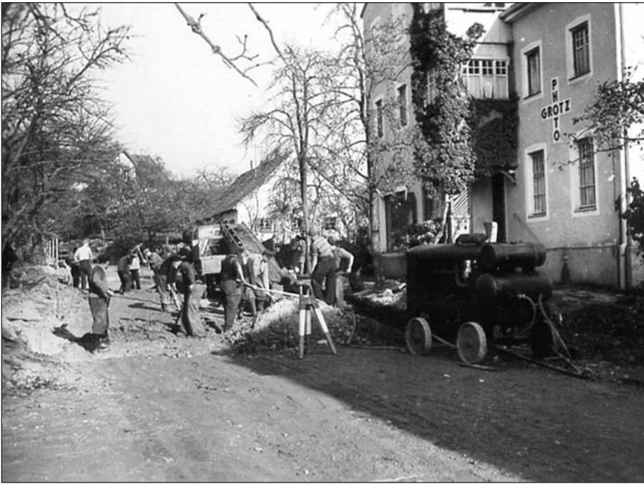
Ausbau der Ortsstraße vor dem damaligen Fotoatelier Grotz (2. Haus rechts nach dem Kriegerdenkmal in der heutigen Straubinger Straße)
