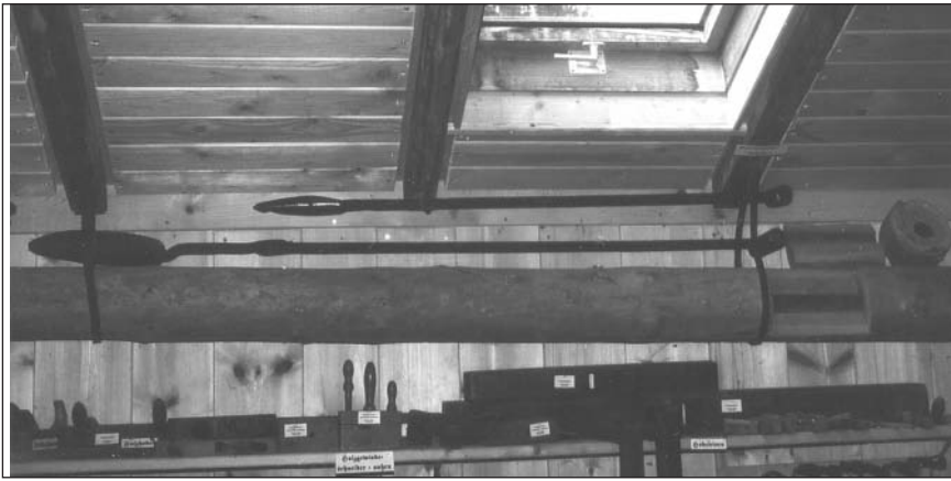
Oben: Wasserleitungsrohr mit Eisenbohrern
