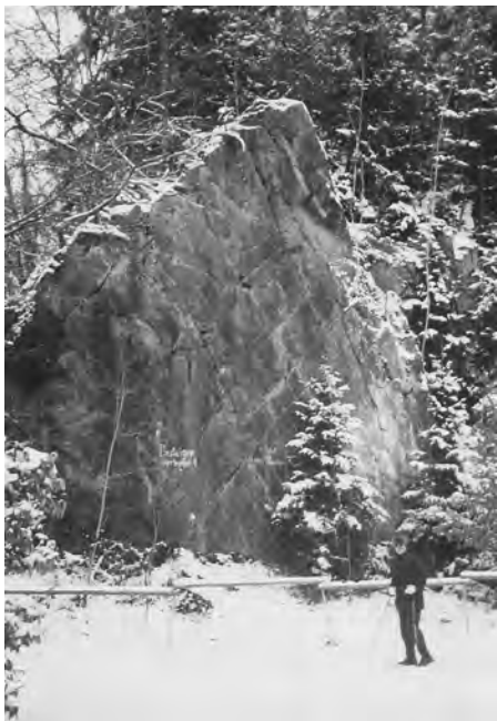
Das Material für den Straßenbau wurde im Steinbruch beim Mitterfelser Waldbad abgesprengt und von einer kleinen Lok in „Roiwagl“ zu einer Steinquetsche etwas weiter bachaufwärts befördert.
