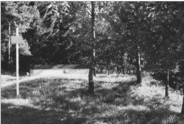
Wasserreserve der Falkenfelder Wasserversorgung
