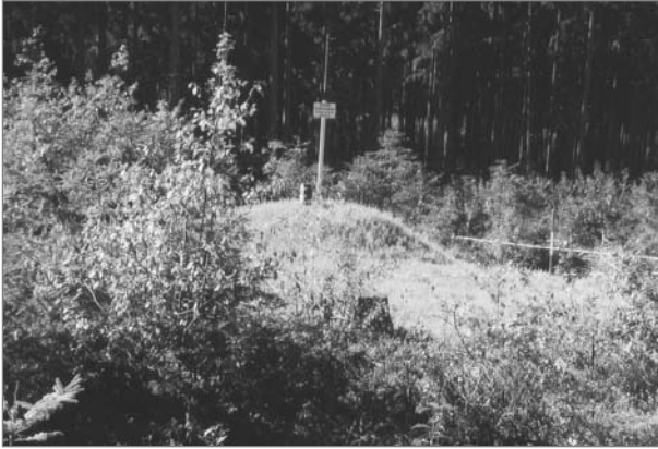
Quelle III der Falkenfelder Wasserversorgung
