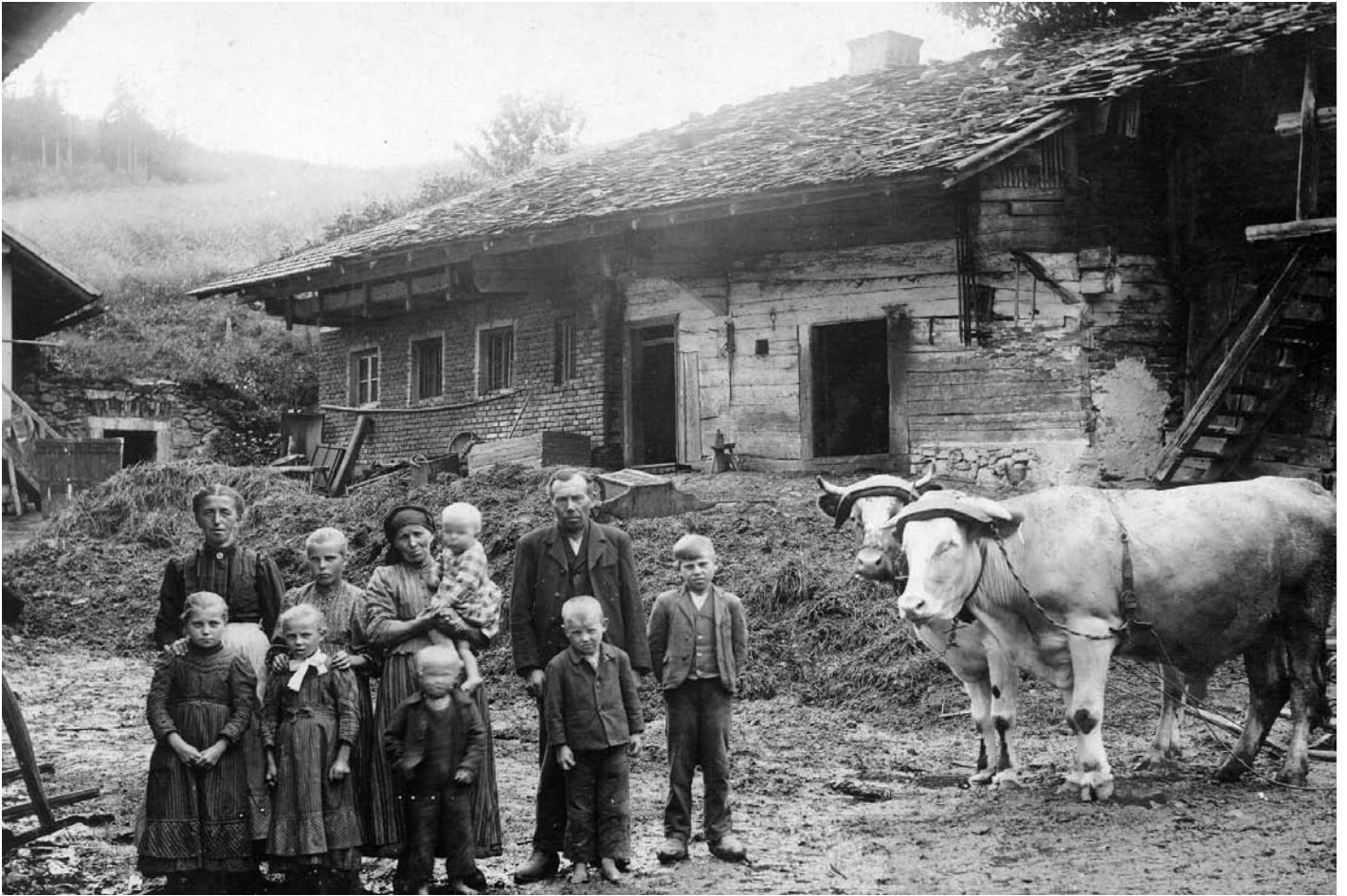
Der Laubnerhof 1913 (heutiger Hausname „Laumerhof“): Der Stall ist noch gezimmert, der Wohnteil bereits mit selbstgeschlagenen Ziegeln gemauert. - Das Bübl vor dem Vater war der vorletzte Bauer auf dem Hof. Sein Sohn und letzte und einzige „Laubner“ verunglückte tödlich. - Heute ist Fritz Binder Besitzer des Laumerhofes.
