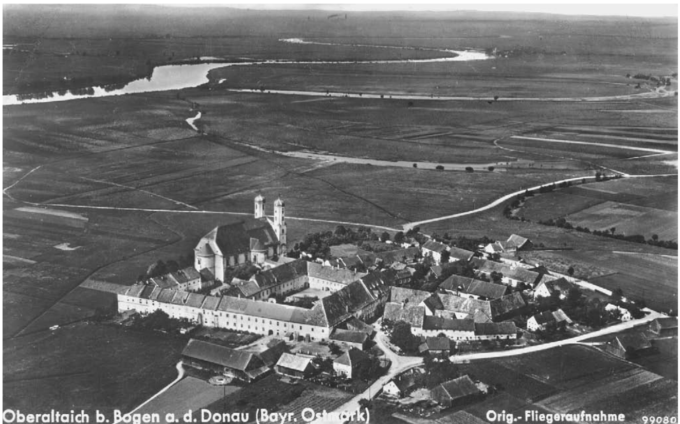
Fliegeraufnahme Oberaltaich: Gut erkennbar ist die beengte Verkehrssituation bei der Mühle (Foto: Verlag Assmus, Leipzig)
