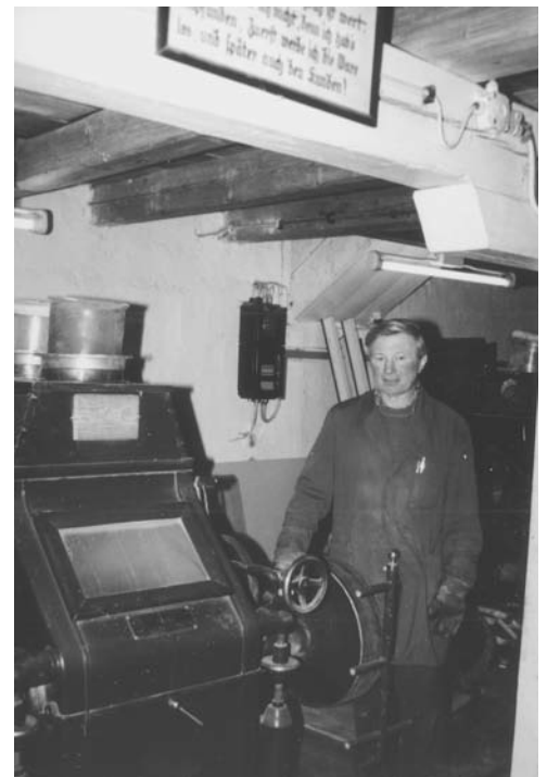
Ein Doppelwalzenstuhl der Fa. „Schwäbische Hüttenwerke“ aus den 30er Jahren
