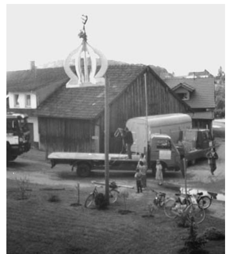
25. Mai 1996: Erneuerung der Zwiebelkuppel - Foto: Martina Spanfeldner
