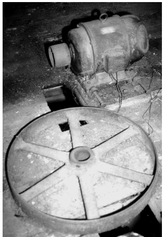
Der Dynamo versorgte das Haus mit Strom. Aus den Löchern im Boden kam der Transmissionsriemen, der den Dynamo in Bewegung hielt. Im Vordergrund ein ausgedientes Transmissionsrad.
