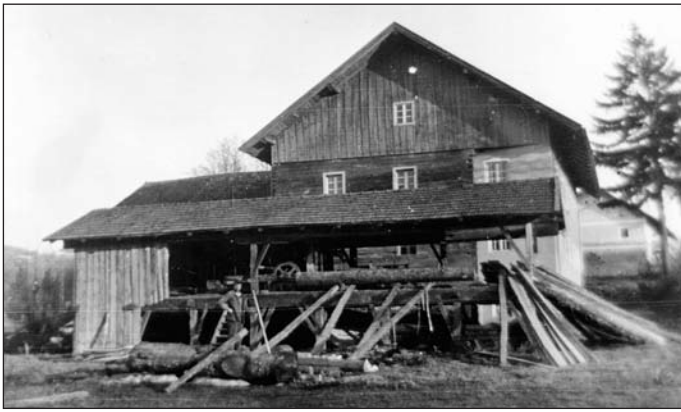
Die Frommrieder Mühle, als das Sägewerk noch stand
