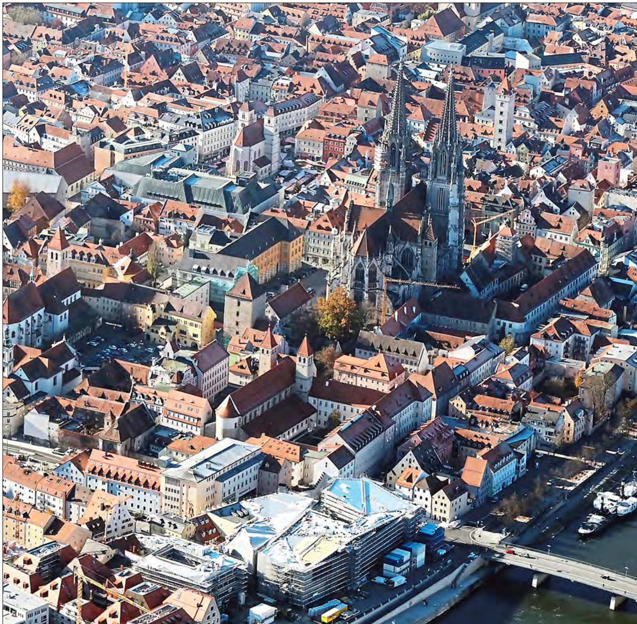
Die Baustelle des Museums der Bayerischen Geschichte am Donaumarkt (Bild unten/Mitte). Den aktuellen Stand kann man über eine Webcam des Bauamts live verfolgen: http://mdbg1.webcam-stbar.de/ . (Foto: Dr. Stefan Satz)
